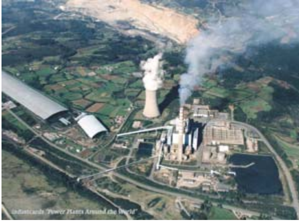
Central térmica de Meirama
