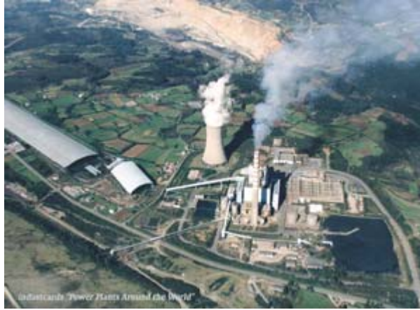
Central Térmica de Meirama
